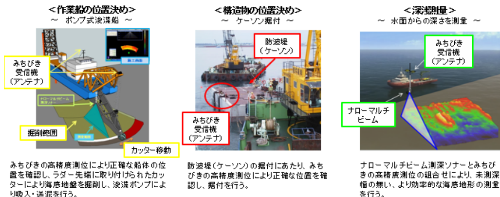
図 21 みちびきを活用した海洋土木工事
